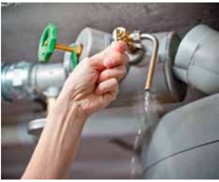
2. Öffnen des Ventils nach erfolgreicher Desinfektion
